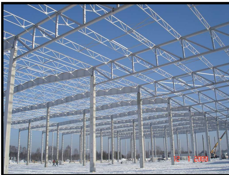
Centrum Logistyki WKREŃT MET w Wanatach k/Częstochowy 550 ton konstrukcji Realizacja : X - XII 2008r
