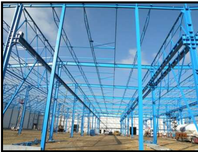
Hala Produkcyjna WKREŃT MET w Wanatach k/Częstochowy 500 ton konstrukcji Realizacja : II - IV 2009r.
