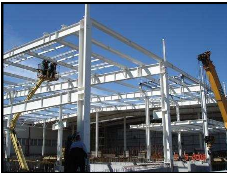
Wykonanie i montaż 350 ton konstrukcji hali produkcyjnej dla TRW Częstochowa. Realizacja : I – III 2008r.
